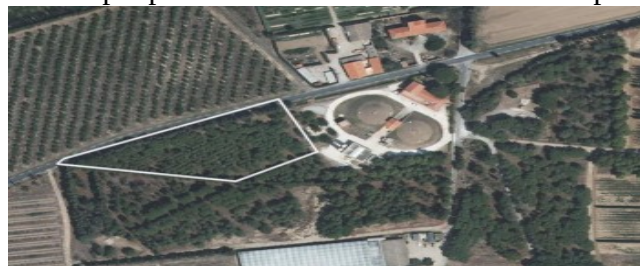
Figure 14 : la pépinière des Pyrénées Orientales (Extraction Géoportail)
